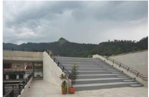
Figura 55: Acesso terraço Fonte: Archdaily
