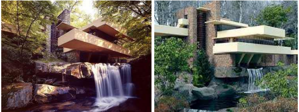
Figura 7 (E) e 8 (D): Casa da Cascata | Fonte: ArchDaily
