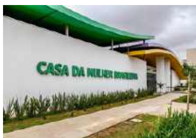
Figura 34: Fachada frontal | Fonte: Site da prefeitura de SP
