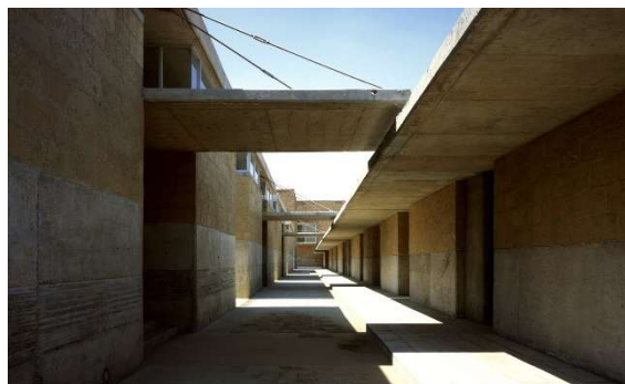
Figura 26: Corredor de acesso as salas de aula | Fonte: Archdaily
