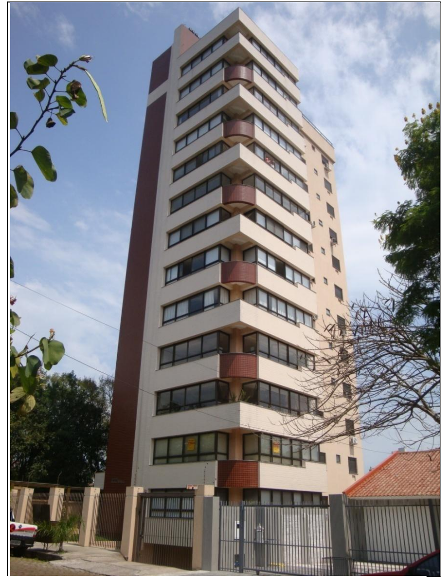
Figura 32 - Edifício Santa Mônica, bairro Centro
