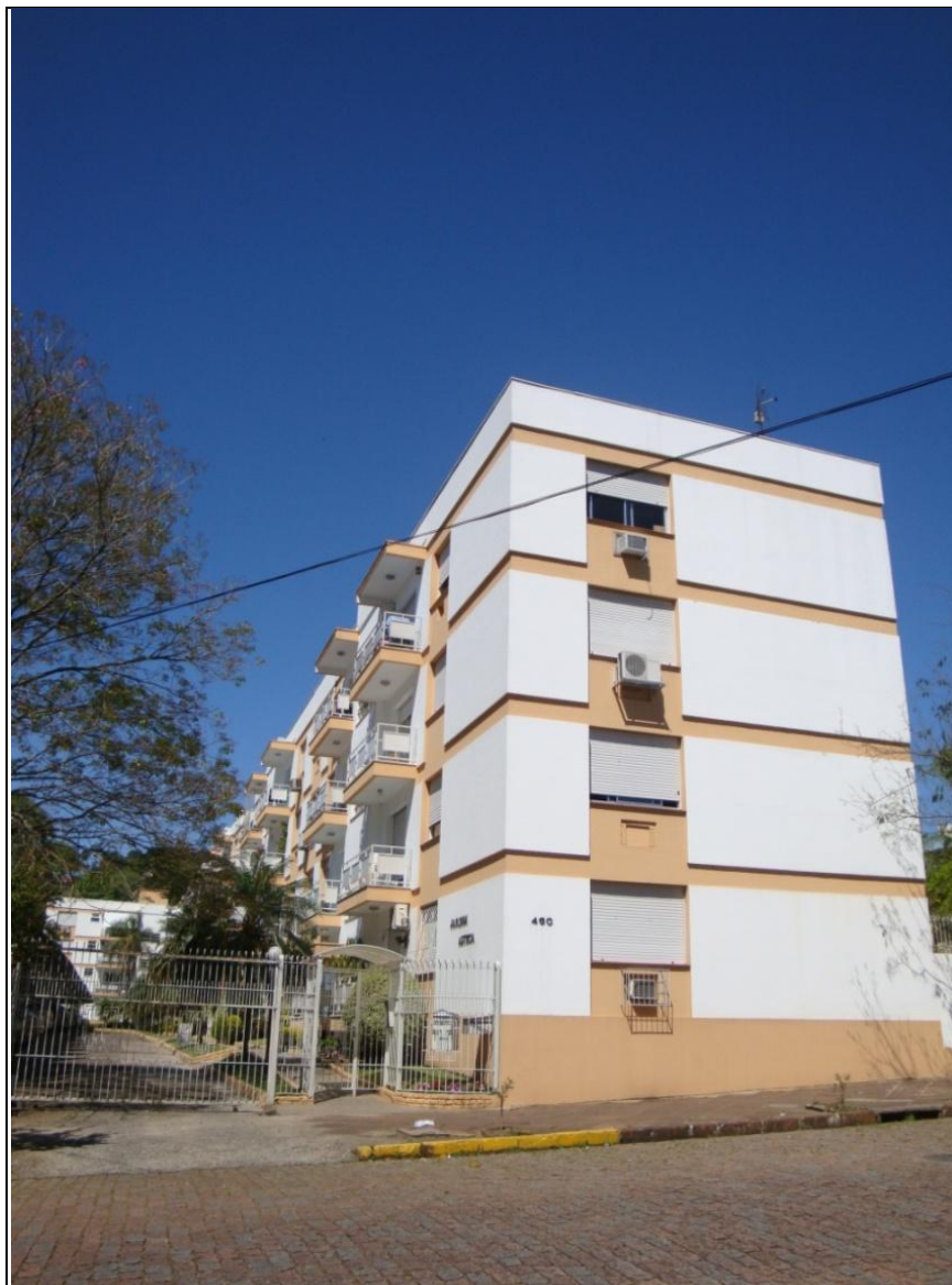
Figura 13 - Edifício Jardim Asteca, bairro Centro
