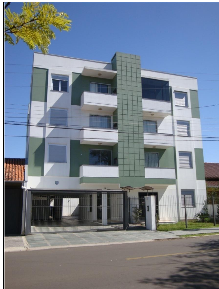
Figura 34 - Edifício Ilhas Caymans, bairro Universitário
