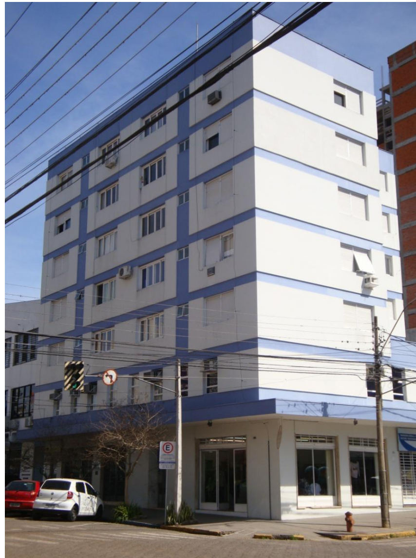
Figura 12 - Edifício Dom Castor Vera Cruz, bairro Centro
