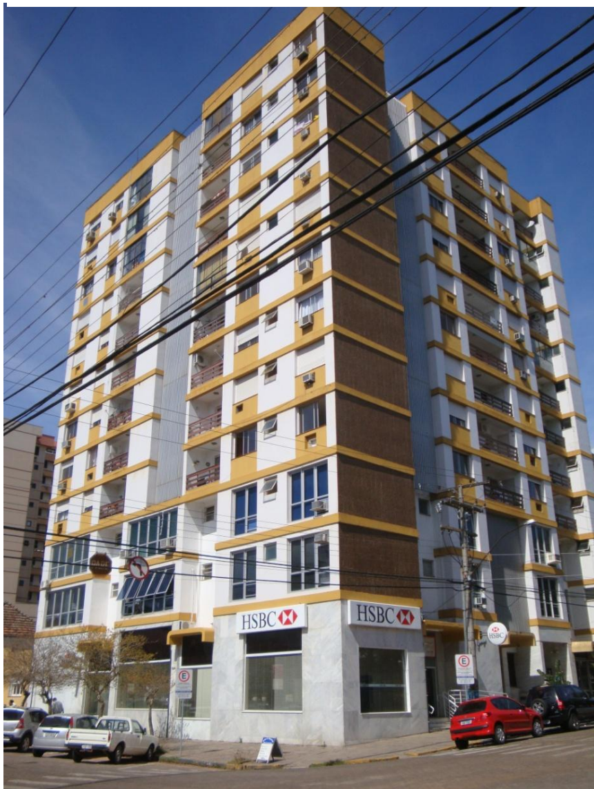
Figura 11 - Edifício Guarujá, bairro Centro
