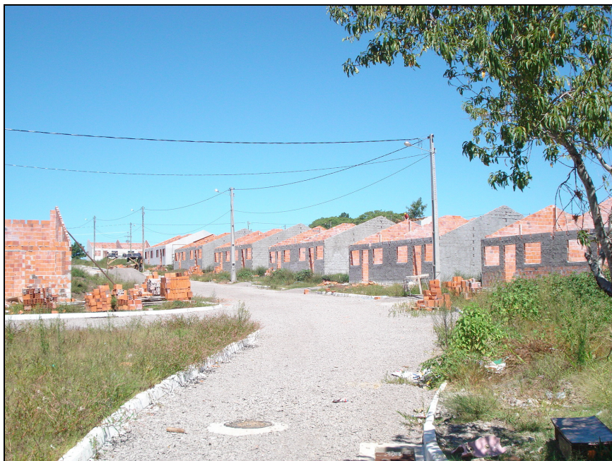
Figura 15 – Casas do Loteamento Cipriano Rocha em fase de construção. Fonte: Registro fotográfico do autor, 2009.
