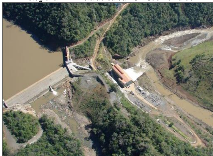
Fotografia 11 – Vista aérea da PCH São Bernardo
