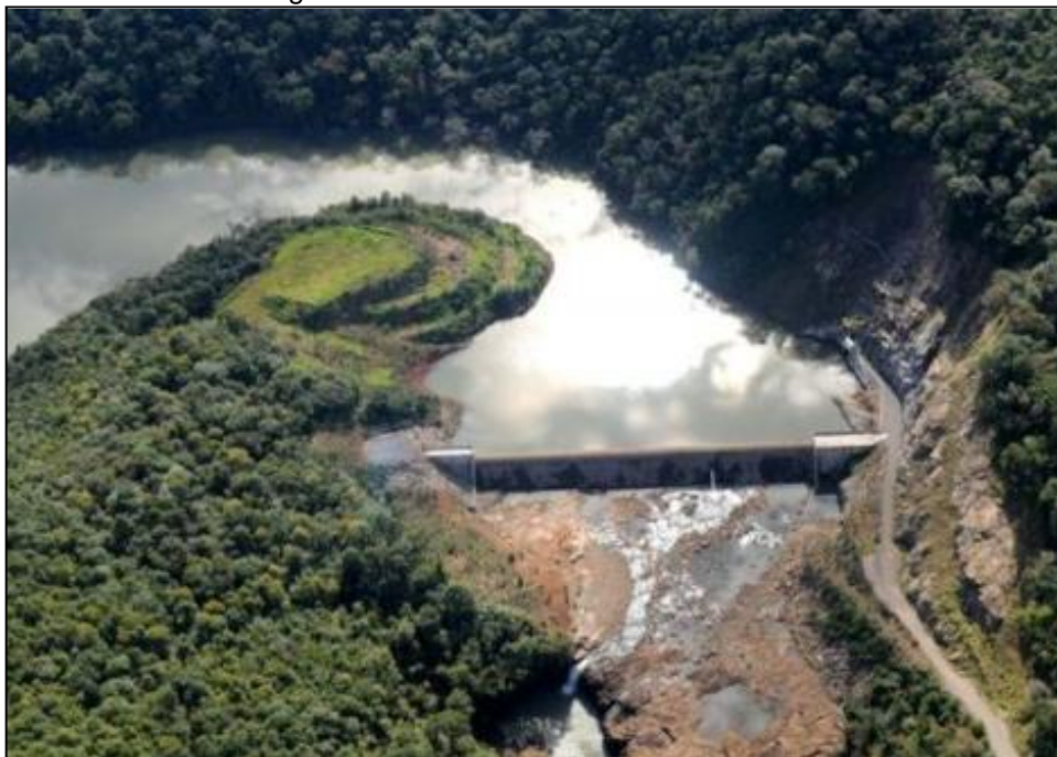
Fotografia 10 – Vista aérea da PCH Esmeralda
