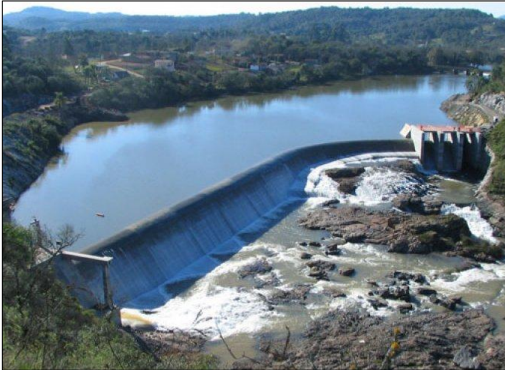
Fotografia 14 – Vista geral do barramento da PCH Caçador
