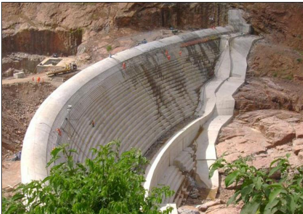
Fotografia 16 - Vista geral do barramento da PCH Linha Emília
