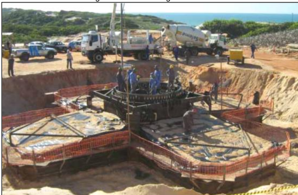
Fotografia 6 – Concretagem das bases
