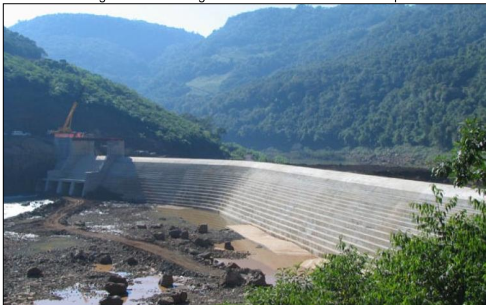
Fotografia 17 – Vista geral do barramento da PCH Cotiporã
