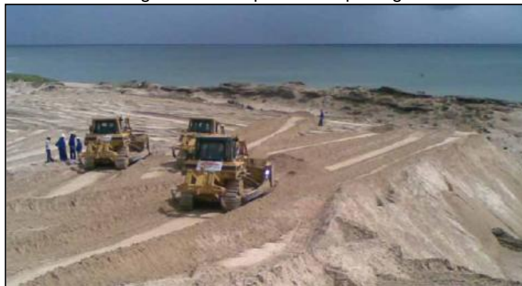
Fotografia 3 – Etapa de terraplanagem
