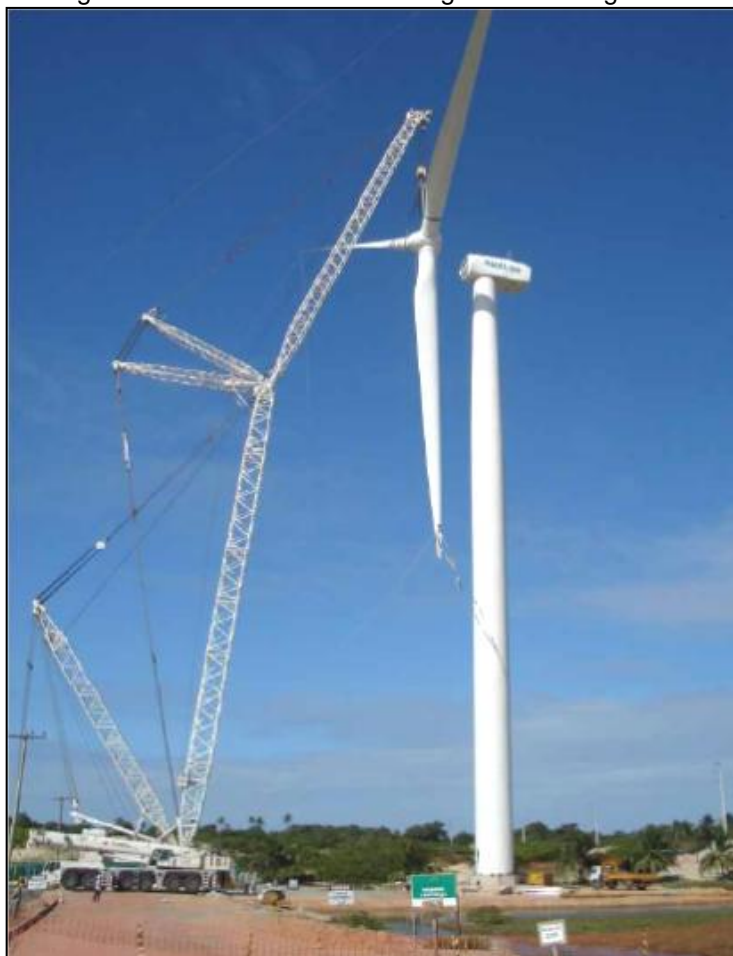
Fotografia 8 – Conclusão da montagem dos aerogeradores
