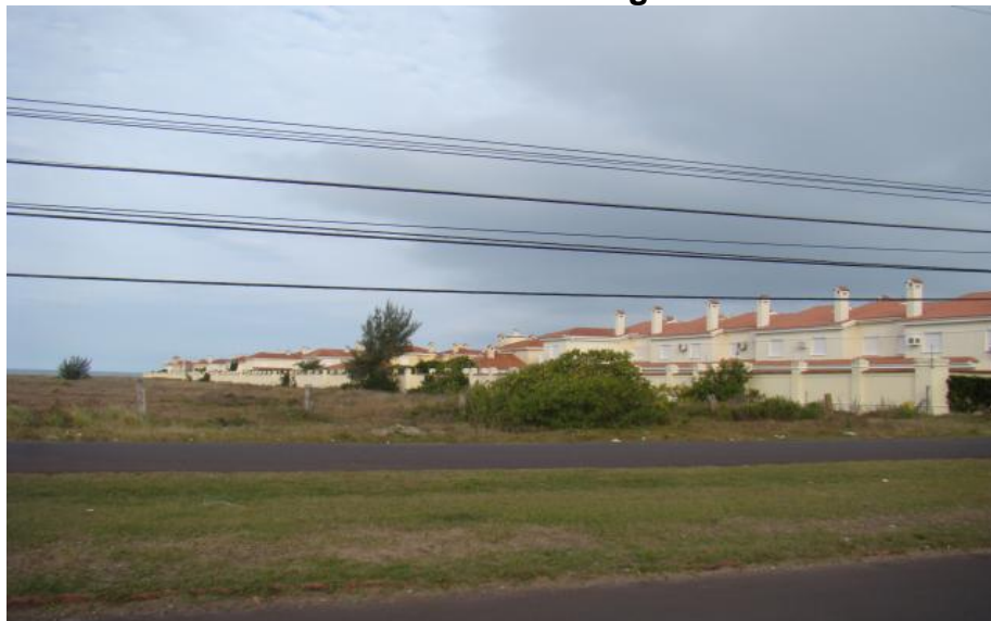
Figura 5 – Condomínio Villas Resort – Xangri-Lá
