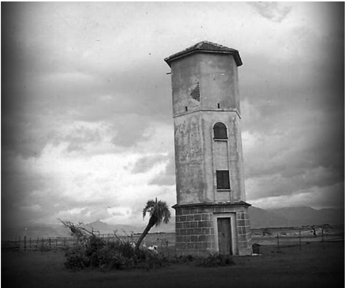
Figura 15 – Antiga caixa d'água em Capão da Canoa
