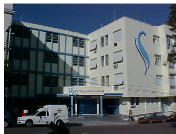
FOTO 2.3: Hospital Santa Cruz na Rua Fernando Abott, área do núcleo de integração; movimento de pessoas com 19.172 atendimentos em 2005
