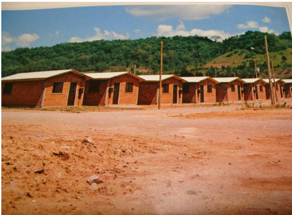
Figura: 03 - Vista do Loteamento Kephas - Início da Construção das Casas, 1984. Fonte: Arquivo Prefeitura Municipal – Novo Hamburgo, 2009.
