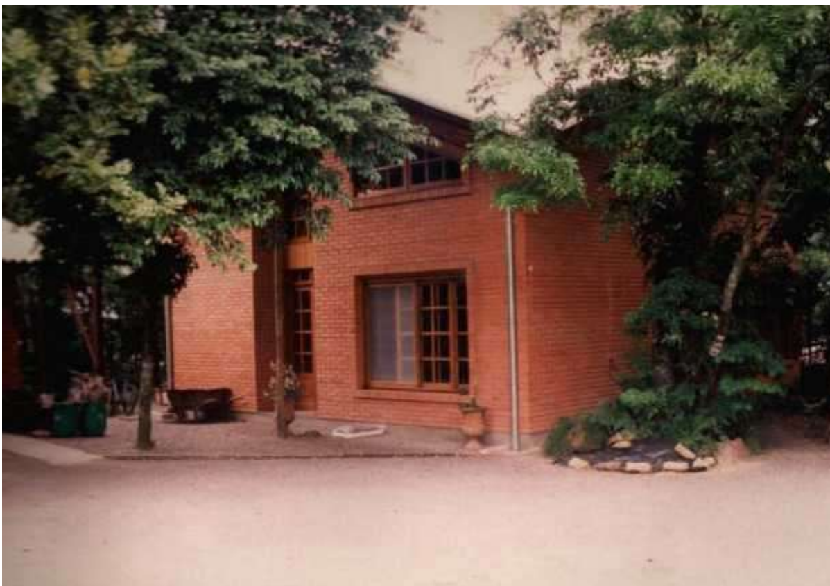
FIGURA 5 - Sede da empresa Entre Ervas Indústria e Comércio de Chás Ltda. Fonte: Entre Ervas Ltda.
