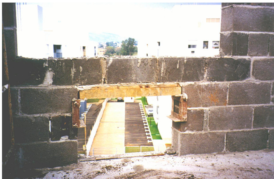
Figura 23 – Execução do vão previsto para colocação do aparelho de ar condicionado.
