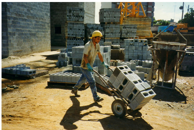
Figura 4 – Carrinho com rodas pneumáticas, adequado para transporte horizontal de blocos.
