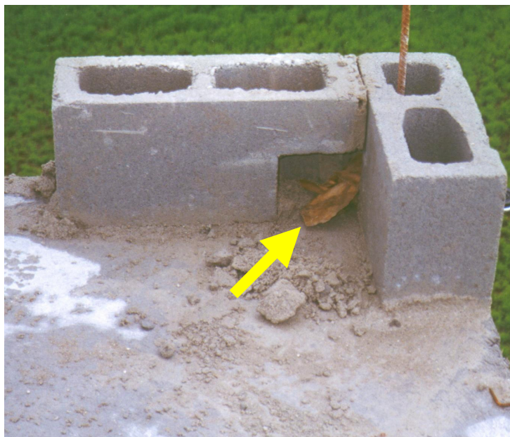
Figura 21 – Cuidado especial (papel) para retirada do excesso de argamassa do interior dos vazados dos blocos a serem grauteados.
