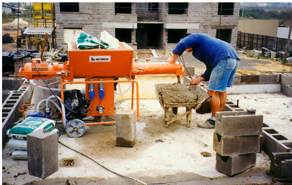
Figura 11 – Misturador de argamassa industrializada com eixo horizontal localizado próximo à alvenaria em execução.
