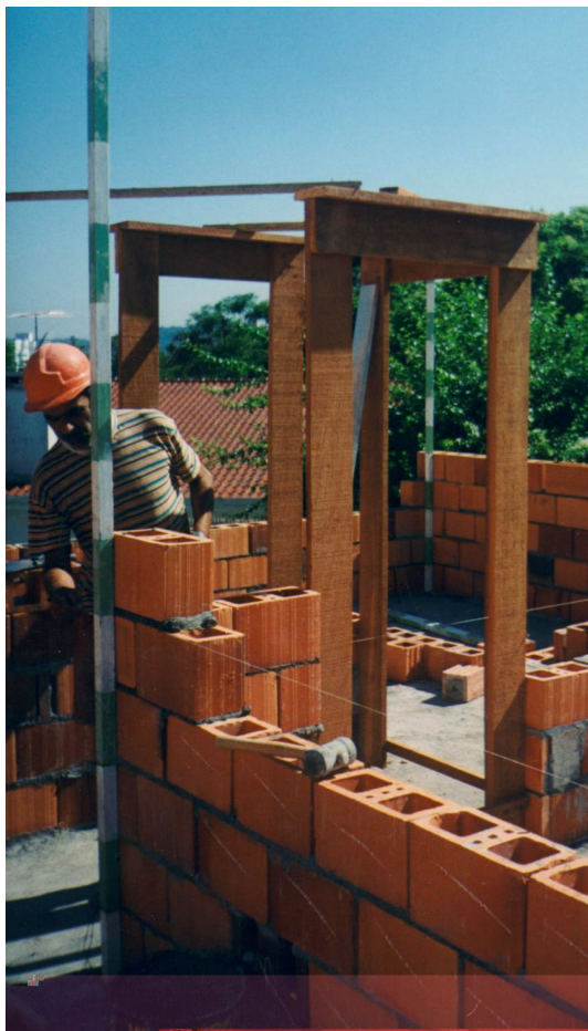
Figura 15 – Escantilhão usado em obras de alvenaria estrutural.
