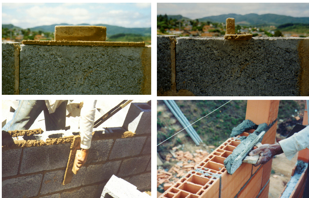
Figura 18 – Palheta utilizada para o assentamento de blocos.
