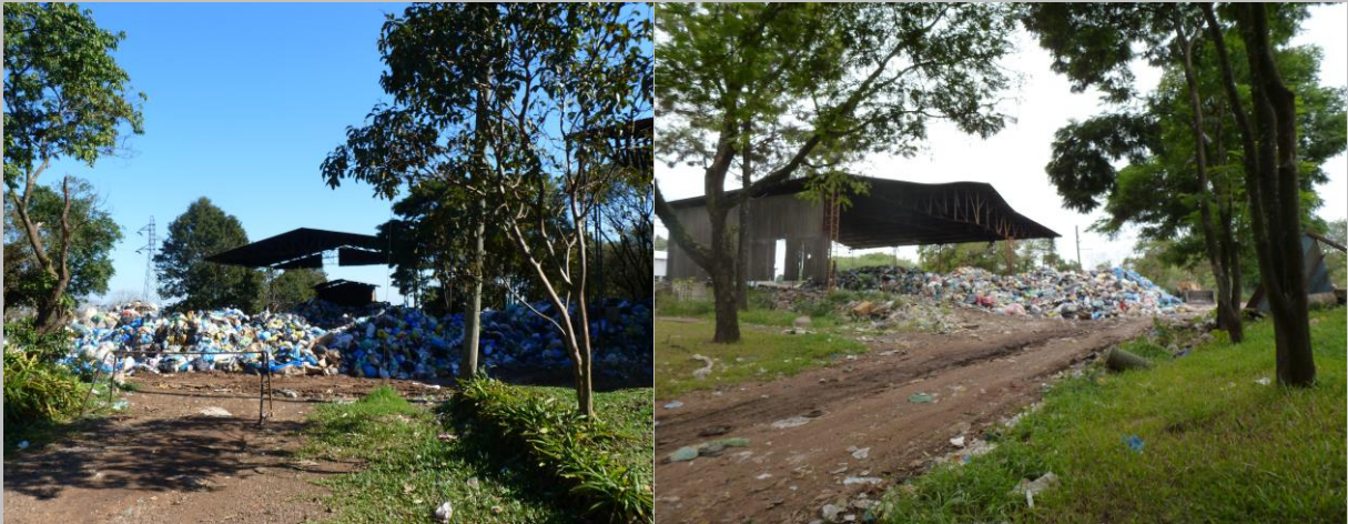
Depósito do lixo que vai ao aterro sanitário
