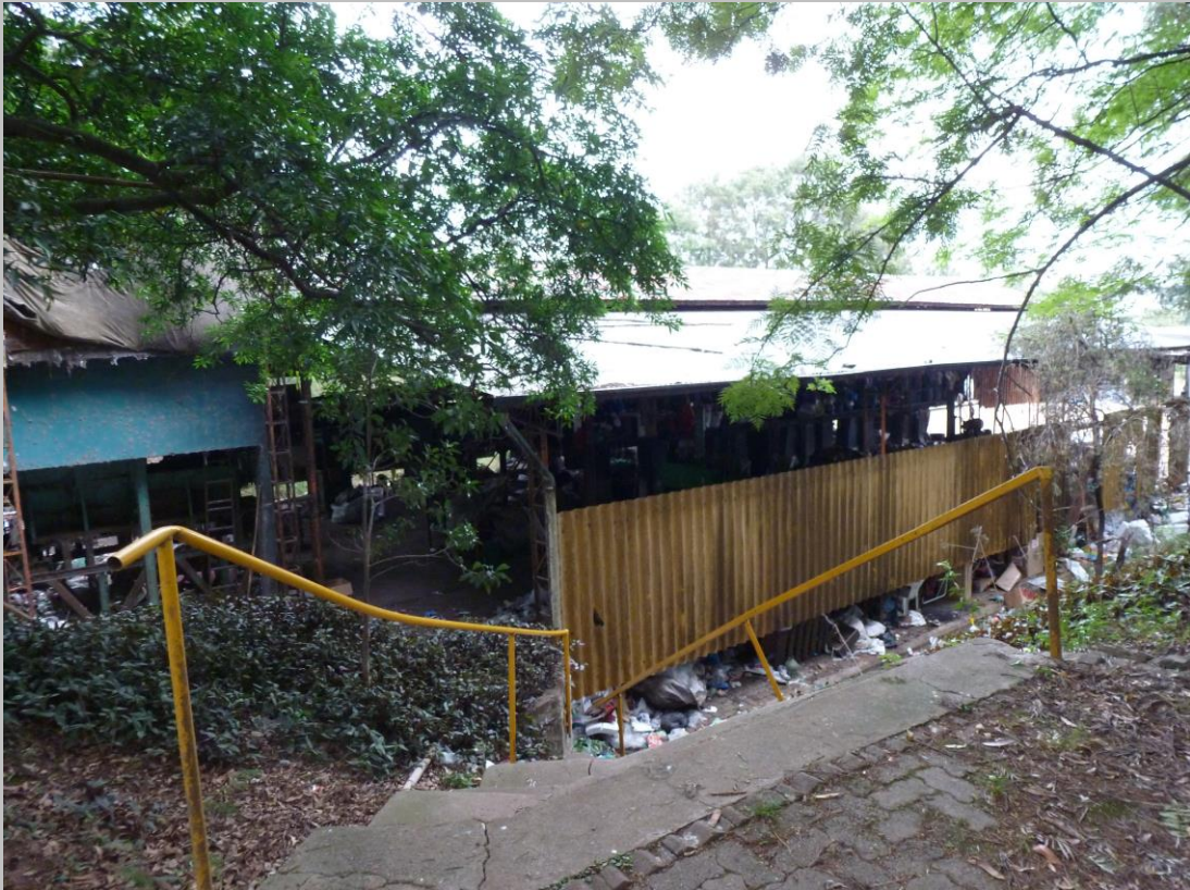
Usina de reciclagem
