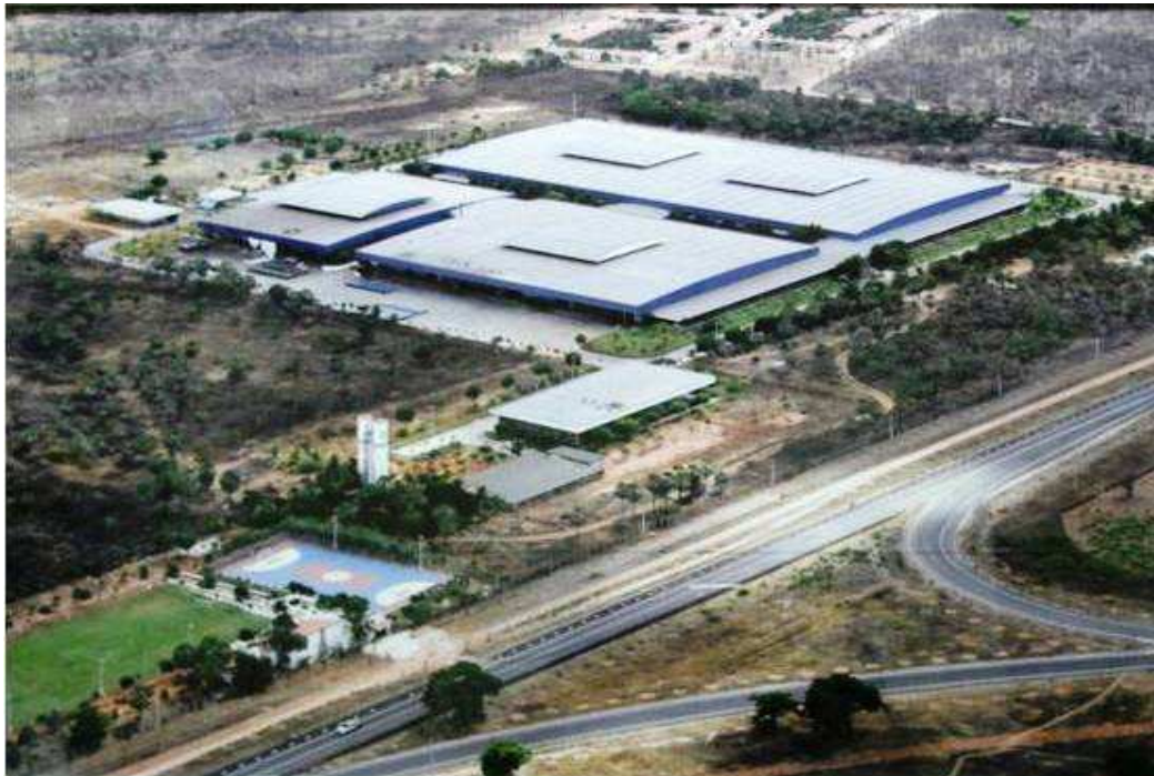
FIGURA 22 - Vista aérea da Unidade Matriz em Russas
