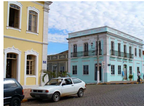
Figura 42 – esquina das ruas Andrade Neves e Ladeira
