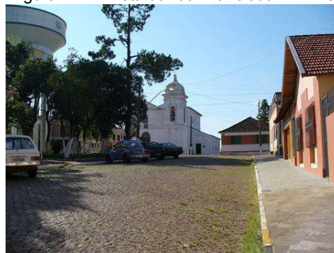
Figura 121 – vista da rua Francisco B. Filho
