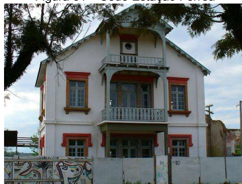
Figura 31 – Sede Estação Férrea
