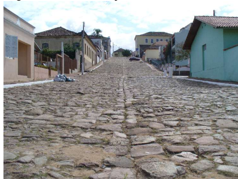
Figura 40 – vista calçamento rua da Ladeira
