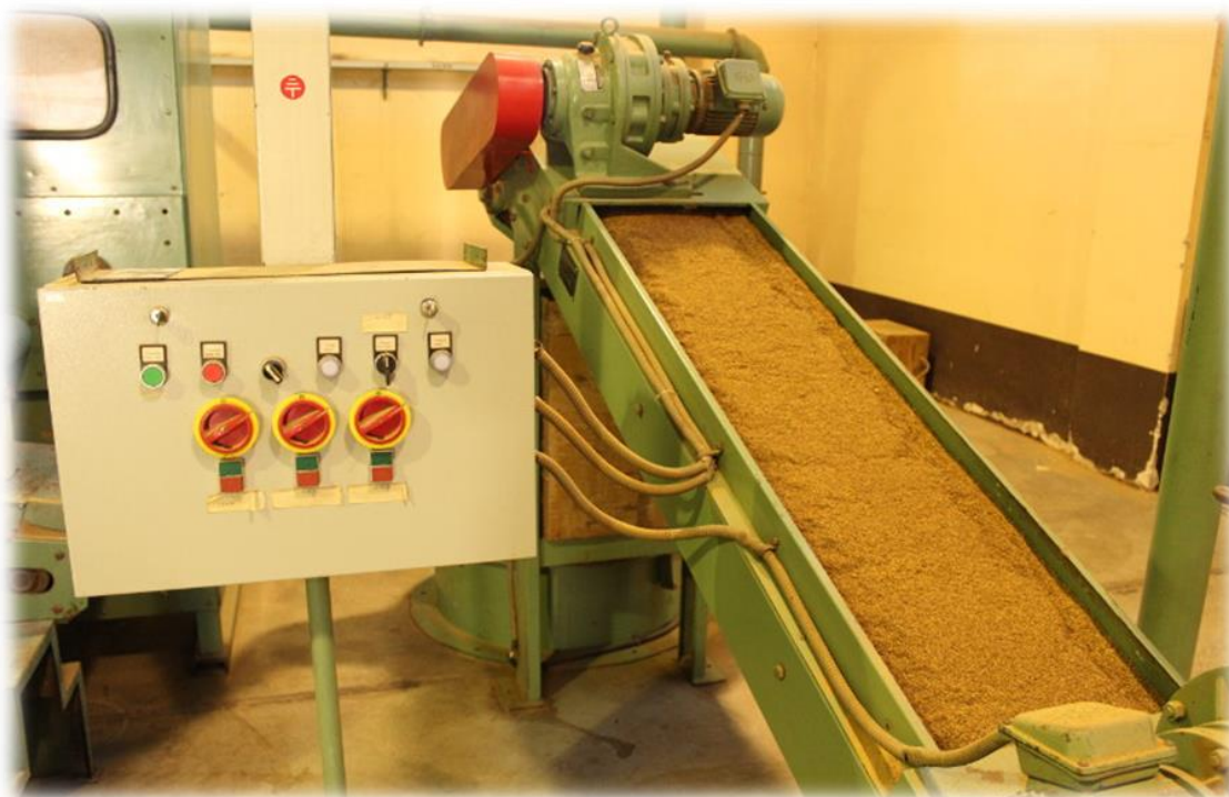
Figura 12 – Foto 5 das máquinas da Usina de tabaco da CTJ
