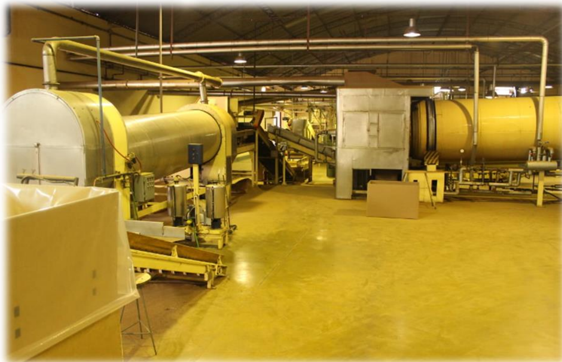
Figura 08 – Foto 1 das máquinas da Usina de tabaco da CTJ
