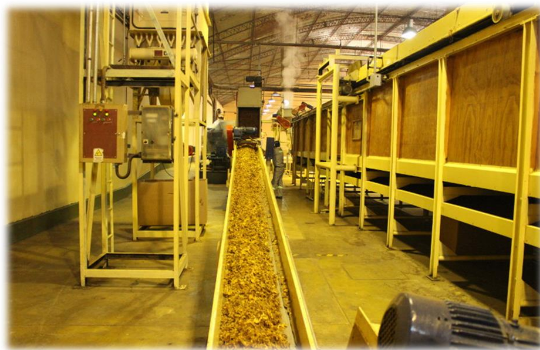
Figura 10 – Foto 3 das máquinas da Usina de tabaco da CTJ
