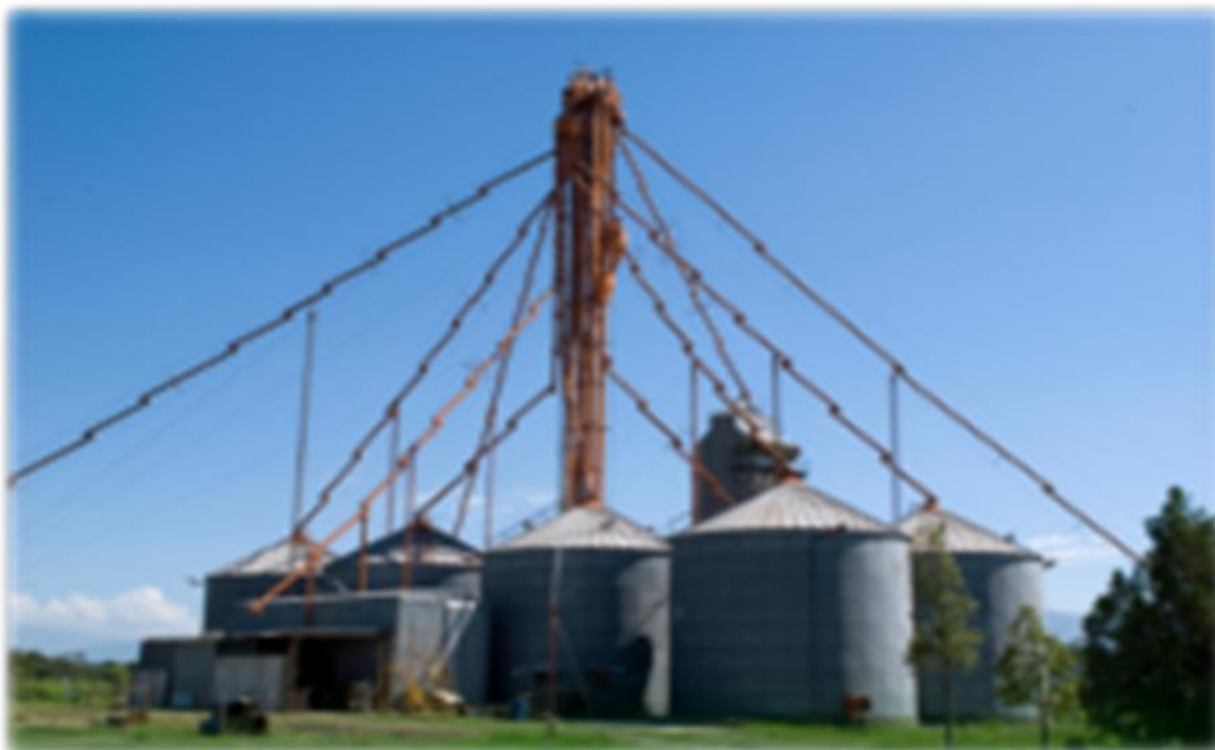
Figura 22 – Foto dos silos para feijão (poroto) na CTJ
