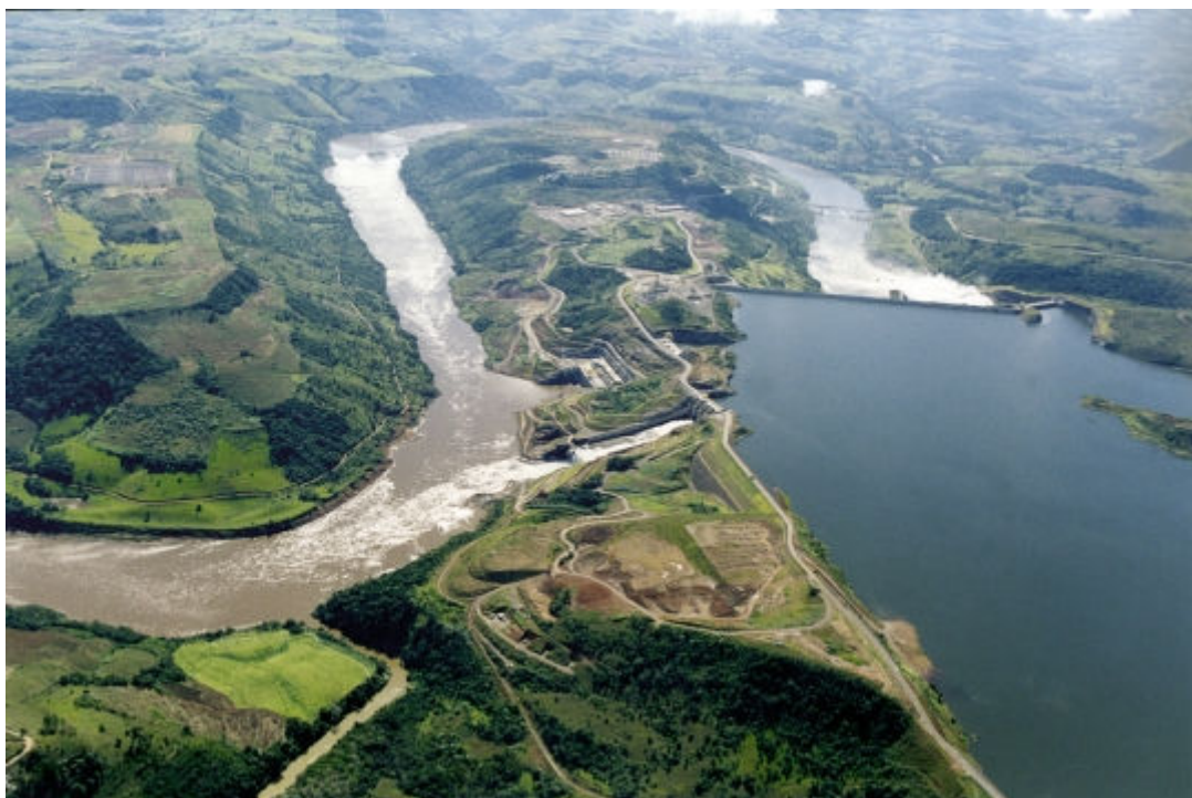
Figura 34 – Volta do Uv, aps a construo da Hidreltrica It (2005)
