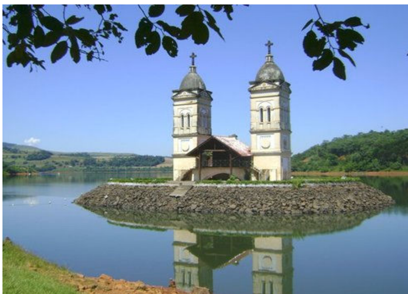
Figura 30 – Foto das torres da Igreja após alagamento
