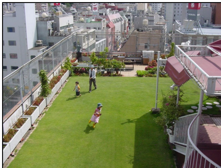
Figura 4 – Telhado verde extensivo (gramíneas)
