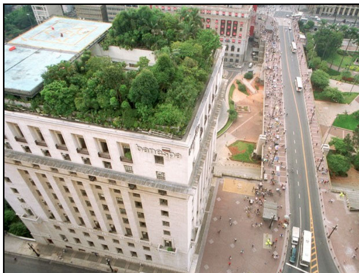
Figura 2 – Telhado verde intensivo
