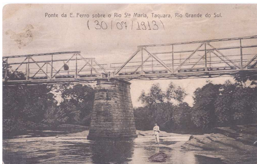
Figura 7 - Ponte da estrada de ferro sobre o rio Paranhana em Taquara, 30/07/1913
