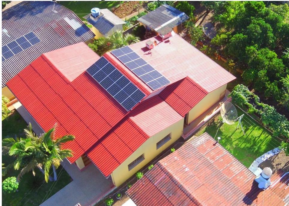
Figura 6 – Imagem da instalação do sistema no local.
