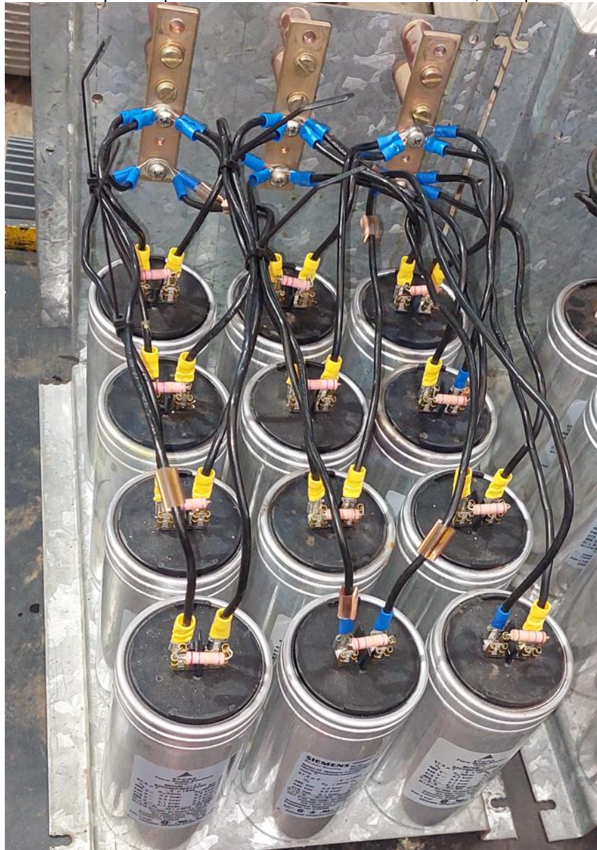
Figura 5 – Banco de capacitor para ser utilizado em uma LT 440VCA, com potência de 50KVAr.
