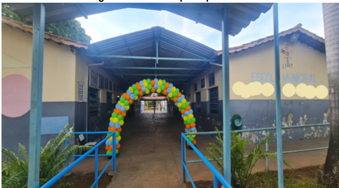
Fotografia 1 - Entrada principal da escola
