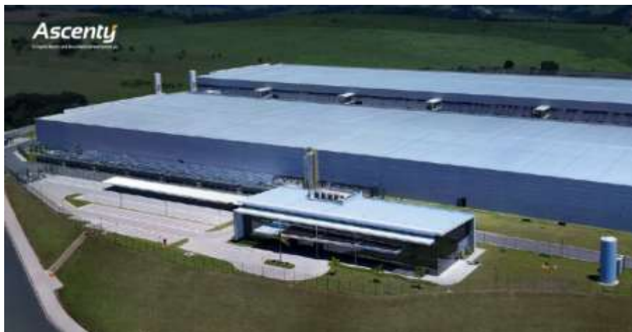
Figura 9 – Sede da Ascenty, empresa de banco de dados localizada em Vinhedo- SP
