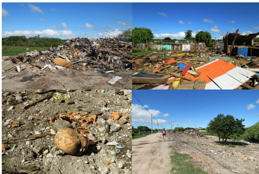
Figura 39. Restos da demolição das moradias da ocupação Estrada do Engenho
