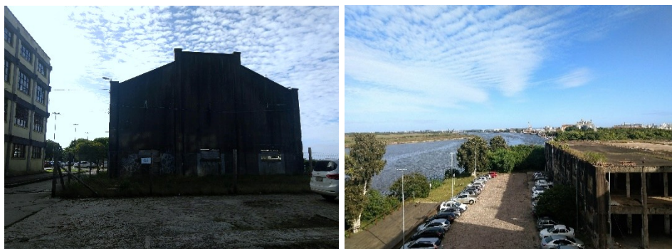
Figura 25. Estruturas no campus parcialmente demolidas
