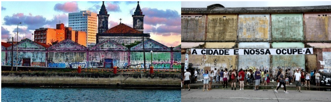
Figura 3. Cais José Estelita antes da demolição dos galpões
