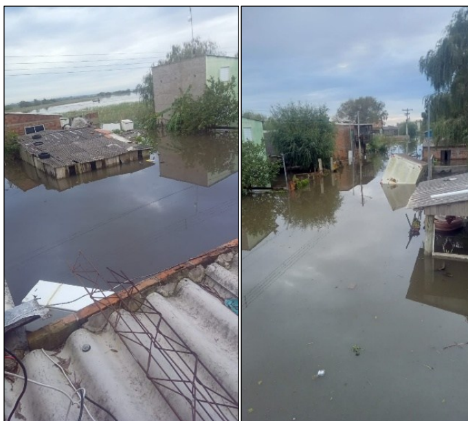
Figura 63. Vista de cima dos telhados das moradias durante a enchente
