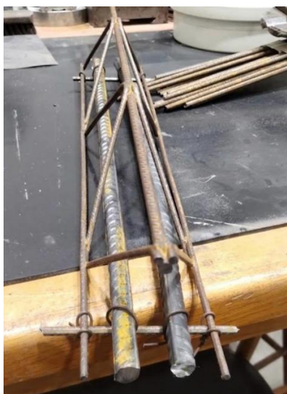
Figura 21 - Amarração das treliças com barra adicional de 12,5mm
