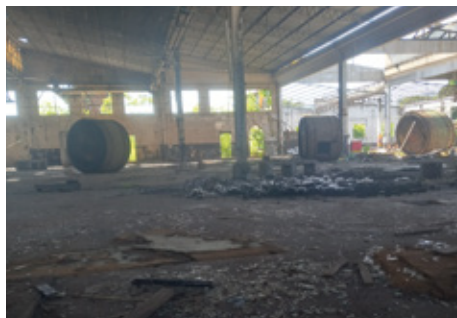
Foto: Encantado/RS - Centro - Janeiro de 2026 (interior de uma fábrica destruída.)
