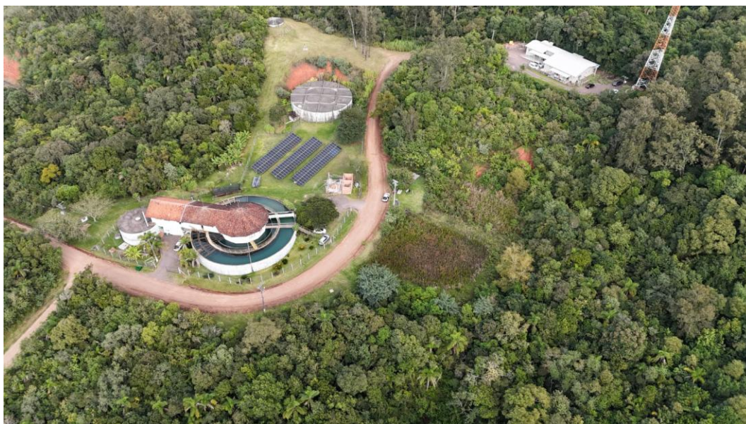
Figura 3 - Visão panorâmica das instalações da Estação de Tratamento de Água (ETA) Central de Vera Cruz/RS, destacando a infraestrutura de tratamento e sua inserção no terreno.
