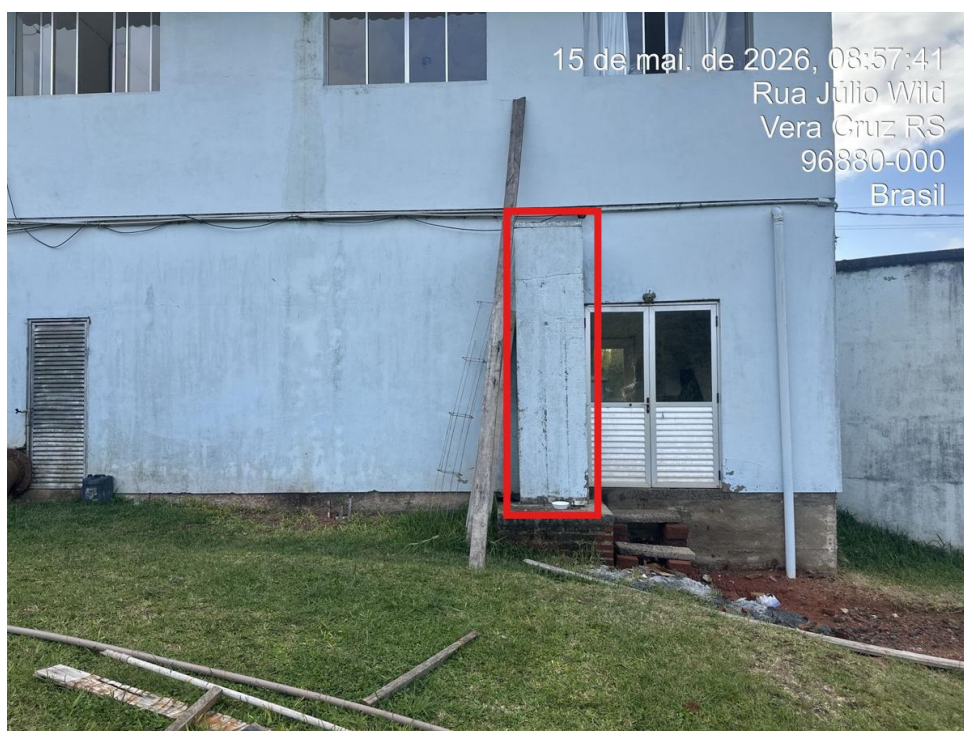
Figura 11 - Detalhe da fachada lateral do prédio operacional da ETA. A coluna sinalizada pelo retângulo vermelho abriga a tubulação de descida gravitacional existente, responsável por transportar o material da lavagem dos filtros em direção às cavas inoperantes.
