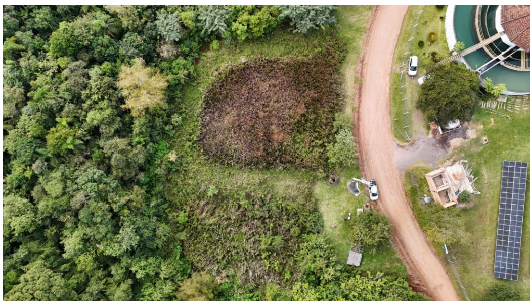
Figura 7 - Vista aérea da ETA de Vera Cruz, com destaque para a área (cavas inoperantes com vegetação) destinada à futura construção dos leitos de drenagem.
