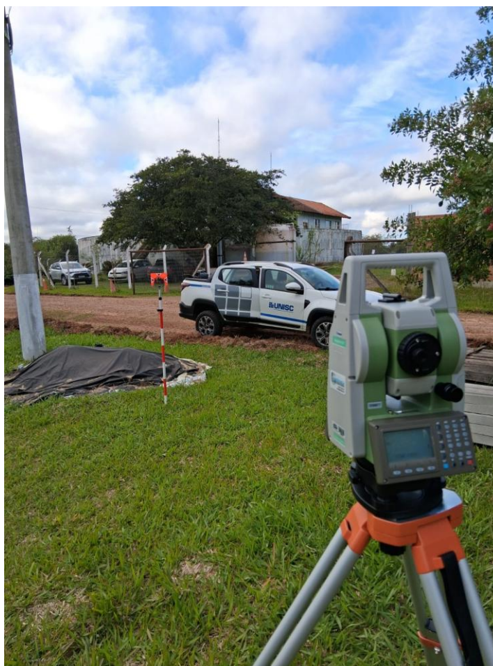
Figura 9 - Operação da Estação Total e visada ao prisma refletor durante a coleta de dados topográficos, visualizando-se a infraestrutura da ETA Central ao fundo.
