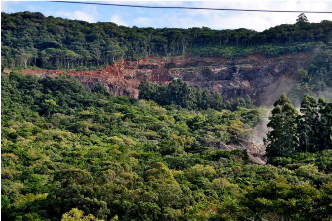
Figura 06 - Pedreira na encosta da BR 101
